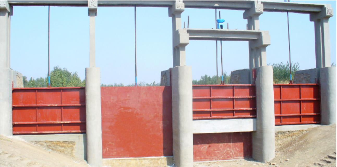
我们将水利闸门进行如下分类：1、如果按闸门的工作性质可分为工作闸门、检修闸门和事故闸门。2、如果按闸门关闭时门顶与水面的相对位置分为露顶式闸门和潜孔式闸门。3、当我们按闸门门叶的外观形状分为平面闸门、弧形闸门、人字闸门、拱形闸门、球形闸门和圆筒闸门等。4、按制造闸门门叶的材料分为钢闸门、铸造闸门、木闸门、钢筋混凝土闸门和组合材料闸门。对于翻板闸门可借助水力自动启闭，称为水力自动闸门。闸门是装于溢流坝、岸边溢洪道、泄水孔、水工隧洞和水闸等建筑物的空口上，用以调节流量，控制上、下游水位、宣泄洪水、排除泥沙或漂浮物等，是水工建筑物的重要组成部分。在水闸工程中，闸门是主体部分，常占挡水面积的大部。闸门又分为平板闸门和弧形闸门。
